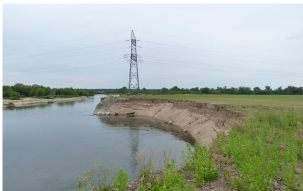
Figure 12 : Pylône en zone de forte érosion de l'Allier
