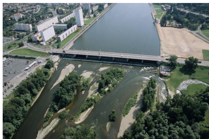
Figure 23 : pont barrage de Vichy (M.Cramois/CEPA, s.d.)
